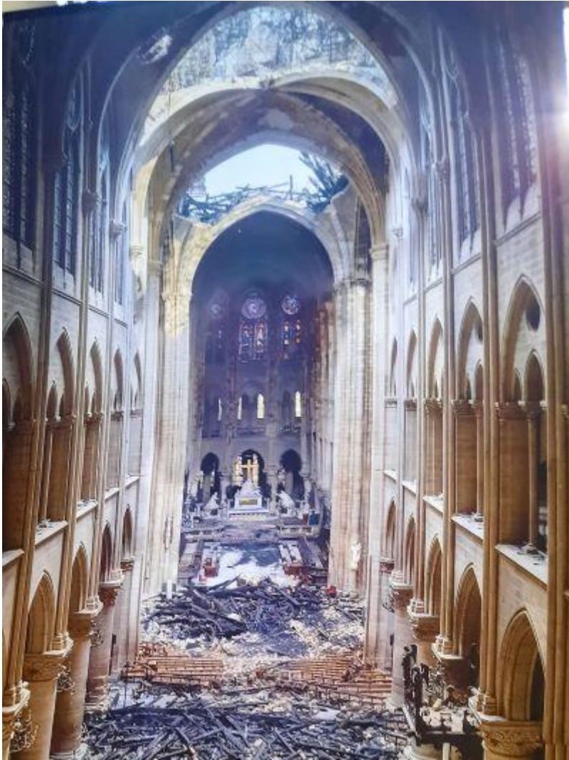
L'intérieur en cours de déblaiement © Etablissement public Rebâtir Notre-Dame de Paris.
